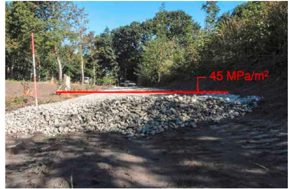
Abb. 27: Grobschottereinbau als Unterbau in unbekannter Dimensionierung bis zum Erreichen der Tragfähigkeit von 45 MPa/m² am 30.08.2016.
