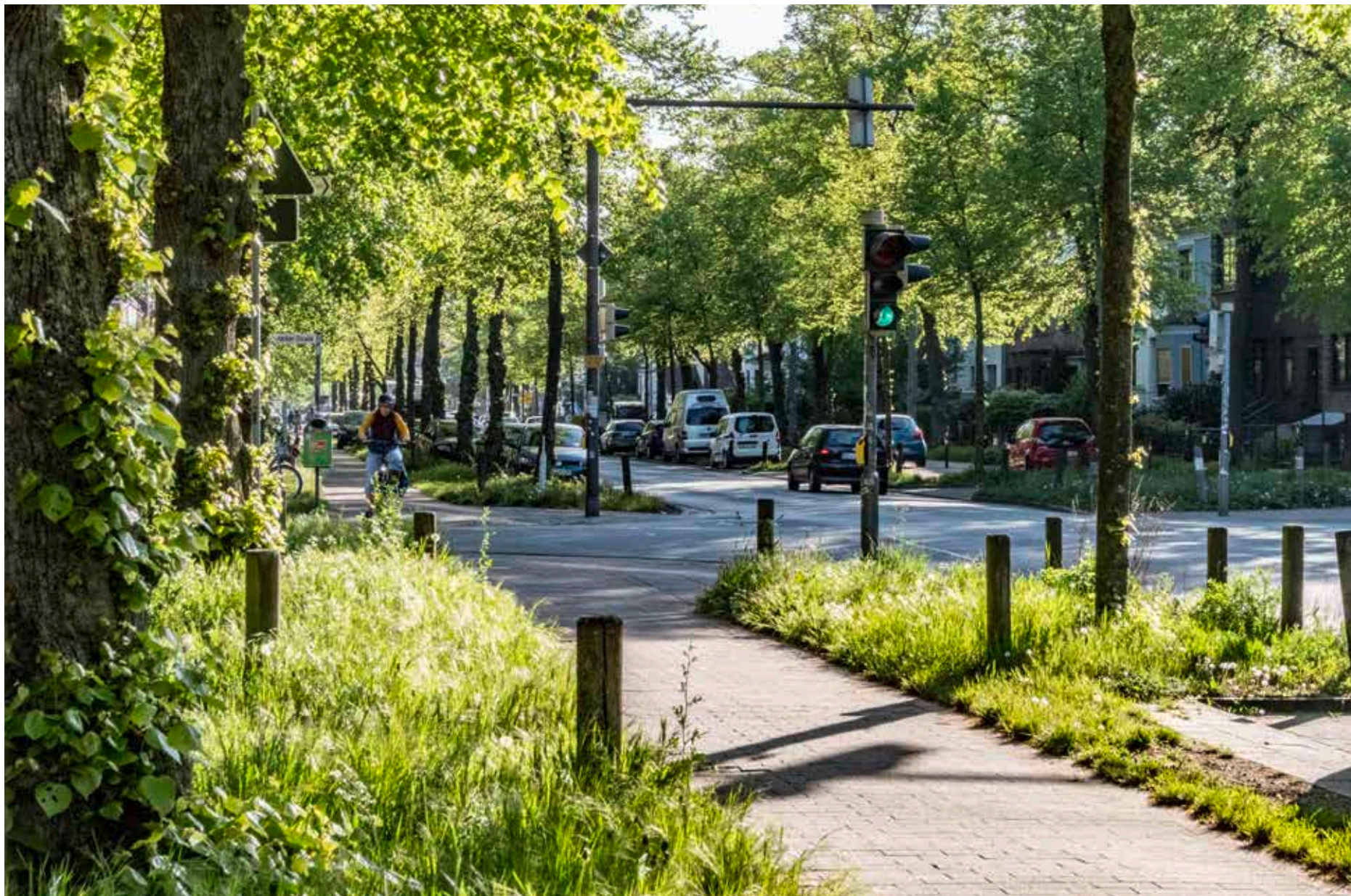
Abb. 51: „Waller Ring“ in Bremen: Radwege unter Alleeebäumen im Stadtraum bei großzügiger Flächenverteilung.
