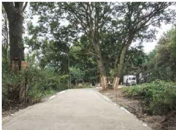
Abb. 28: Fertiggestellte und verdichtete Radwegetrasse im Altbaumbestand am 16.09.2016.
