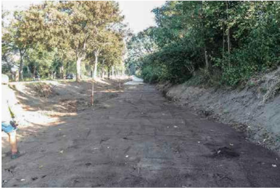
Abb. 26: Fertige abgesteckte Trasse mit eingebautem Wurzellockstoff als Nährstoffdepot am 02.09.2016.
