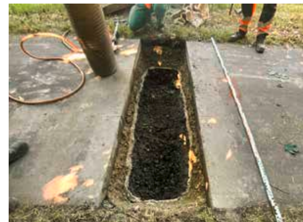
Abb. 30: Öffnung des Radweges im Mai 2025 zur Erkundung der Wurzellage.
