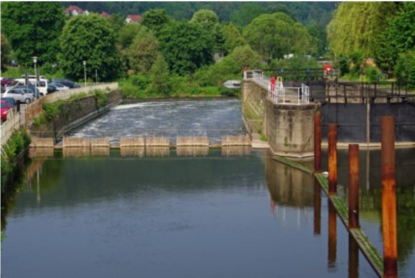
Abb. 26: Nadelwehr mit Schleuse in Hann. Münden.
