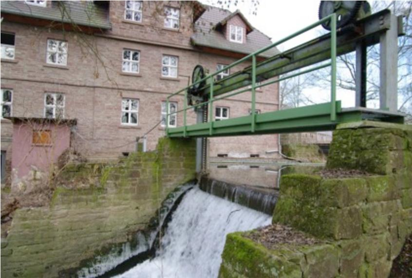
Abb. 21: Die Mühle in Forst (von 1834, Mühlenstandort von 1437) nutzt das Wasser des Forstbaches zur Gewinnung elektrischer Energie. Sie ist die letzte von mindestens acht ehemaligen Mühlen am nur 14 km langen Forstbach.
