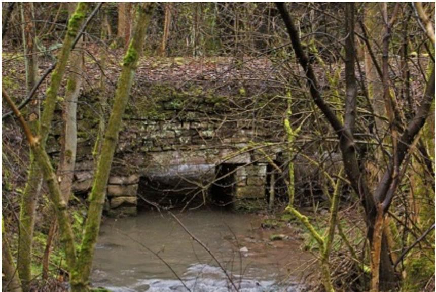
Abb. 6: Brücke aus Buntsandstein über den Forstbach im Hooptal (Lkr. Holzminden) als Zugang zu einem Steinbruch.
