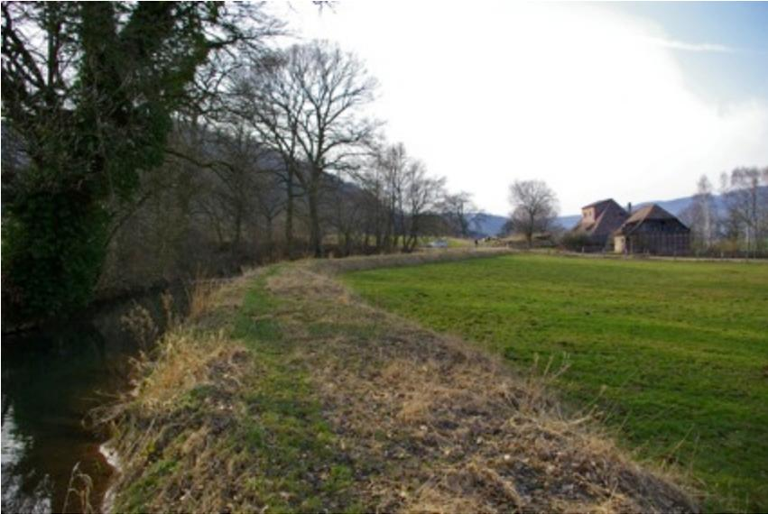
Abb. 22: Der Mühlgraben der Duhnemühle bei Negenborn (Lkr. Holzminden) wird auf einem Damm geführt.
