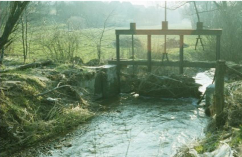
Abb. 25: Dreiteiliges Schützenwehr zur Wiesenbewässerung in der Ahle im Solling (Lkr. Northeim). Vor dem Wehr links befindet sich die Ableitung zum Bewässern der Wiesen.
