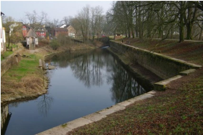
Abb. 12: Der ursprünglich größere Weserhafen in Holzminden von 1837 hatte eine reine Schutzfunktion für Transportschiffe.
