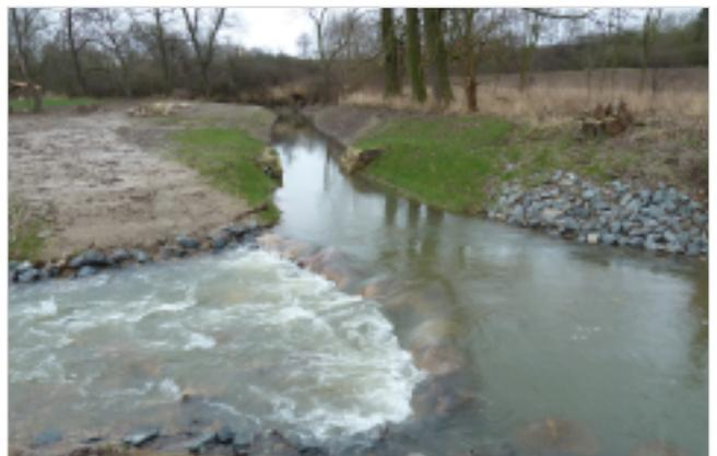
*Das neue Abschlagbauwerk Saale-Mühlgraben. Die nach dem Wehrabriss wieder durchgängige Saale fließt von rechts nach links; der Wasser führende Mühlgraben liegt im Hintergrund. Foto: R. Halbauer, Landkreis Hameln-Pyrmont.*
