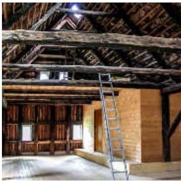
Das Dach wurde ganz bewusst nicht ausgebaut, weil man dafür viel Geld hätte einsetzen müssen, da man so viel Nutzfläche nicht braucht und zudem die – dank Wartungsvertrag – noch intakte Sandsteineindeckung gelitten hätte. Der Dachboden wurde mit Blick auf die KfW-Vorgaben gut gedämmt, ein vermutlich ökologischer Ansatz, aber bis dato kein rentierlicher Aufwand.
