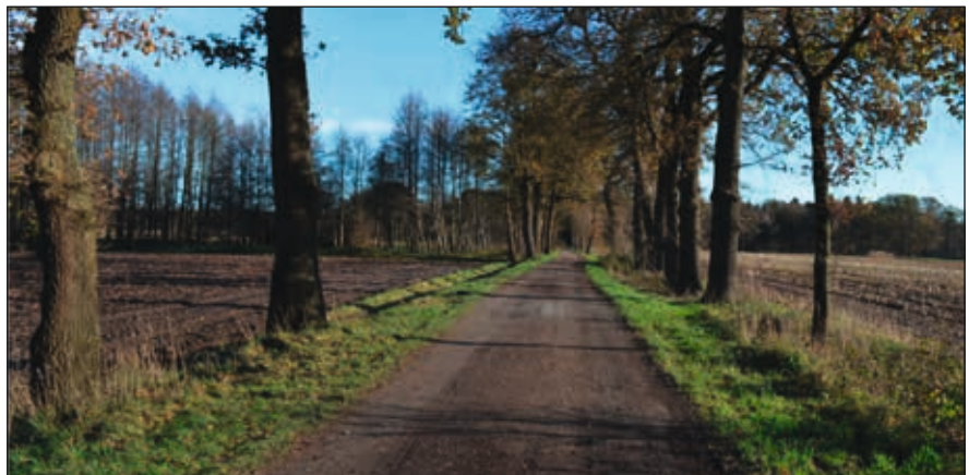
Abbildung 40: Wassergebundene Wegebefestigung (Quelle: Ge-Komm GmbH)
