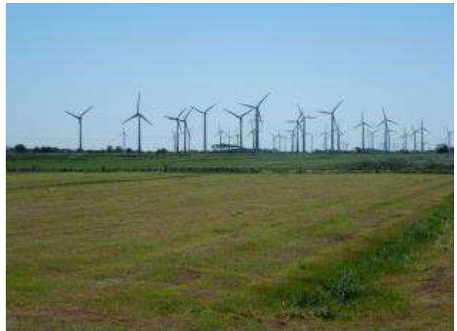
Ein Thema in der RM 2022: Der forcierte Ausbau der Windenergienutzung, wie hier bei Utgast im Landkreis Wittmund, erfordert eine abgewogene und verbindliche Raumordnung, damit der Kohlendioxid-Ausstoß reduziert werden kann und unsere heimische Landschaft weiterhin lebenswert bleibt. Foto: Heinz.
