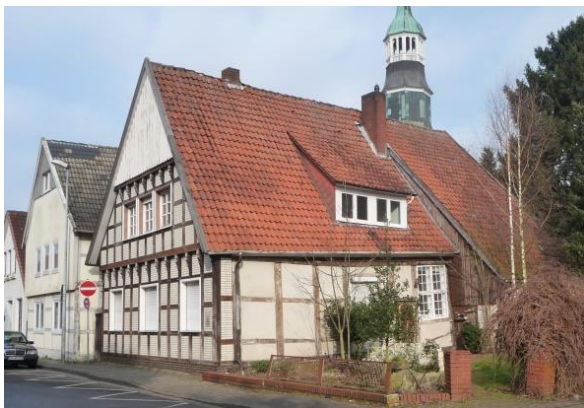
Rettung des Geburtshauses des Reformators Hermann Bonnus in Quakenbrück: ROTE MAPPE 2017. Foto NHB
