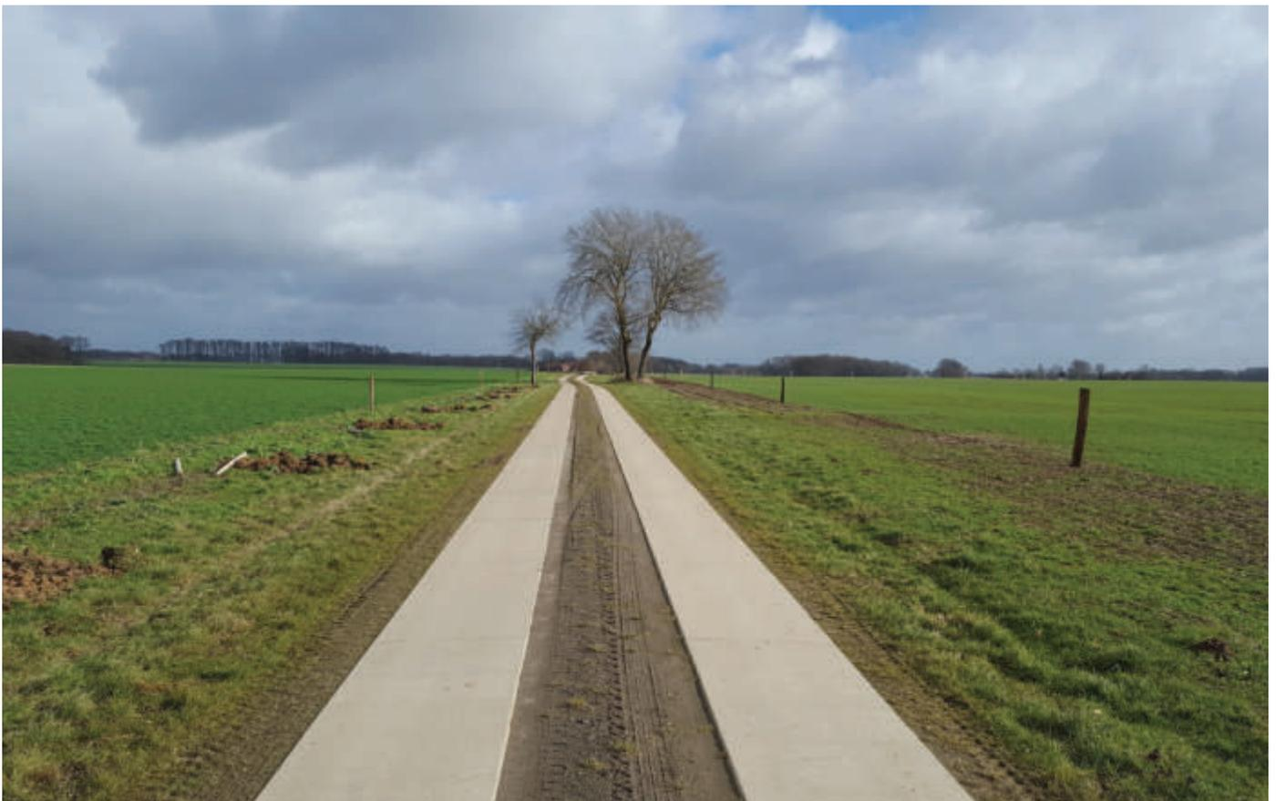
Abbildung 3: Neue Betonspurbahn nebst Ausweisung der Wegeseitenränder inkl. Eichenspaltpfählen zur Sicherung der Seitenränder
