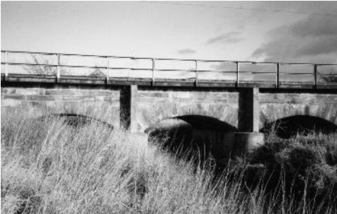
Abb. 24: Eisenbahnbrücke über die Bückeburger Aue. (Foto: A. Thielemann)
