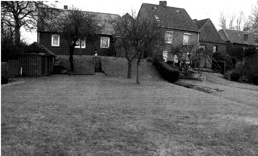
Abb. 19: Die Warft Middelsbur liegt zwischen Dornumersiel und Bensorsiel. Die Erde wurde bis dicht an die Häuser heran abgetragen (Foto: Tatjana J., 2005)
