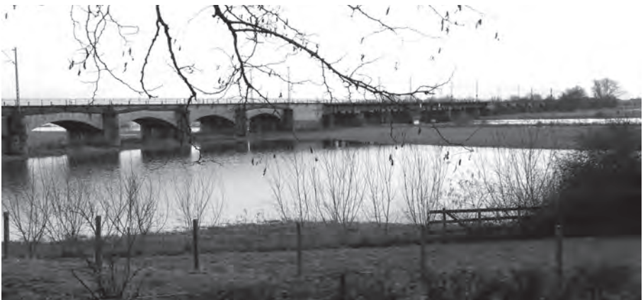
Eisenbahnbrücke über die Aller bei Verden. Foto: R. Olmski.
