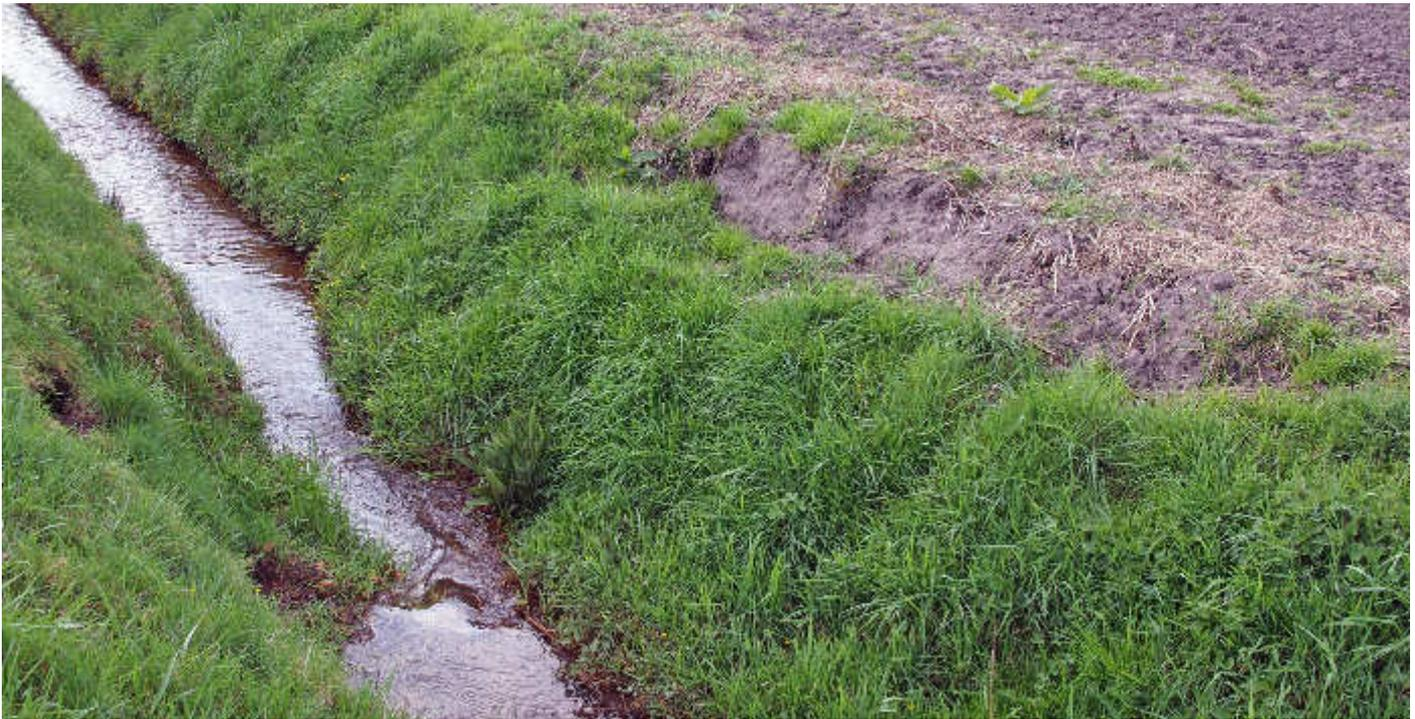
Wie hier, am Moorbach in Fürstenau (Landkreis Osnabrück), wird häufig ohne ausreichenden Abstand zur Oberkante der Grabenböschung geackert. Dabei kann u.a. die Böschung in den Graben rutschen und diesen beeinträchtigen. Foto J. Schwietert.
