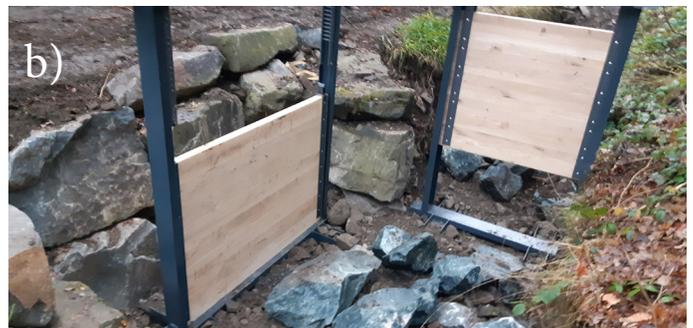
*Nach langem Planungsprozess konnte die ökologische Durchgängigkeit des Harzbaches Sieber im Oberlauf durch teilweisen Rückbau der Wehre II (Abb. a) und III wieder hergestellt werden. Dabei konnten denkmalgeschützte Teile erhalten werden oder wurden saniert, wie die Steuerungsorgane am Betriebsgraben (Abb. b). Foto: D. Sohns.*
