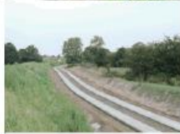
Fertige Betonspurbahn
