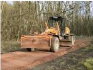
Einbau der Tragschicht mittels Grader oder Fertiger
