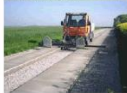
Schneiden der Scheinfugen
