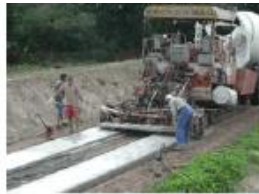
Betonspurbahnfertiger im Einsatz
