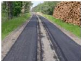
Fertige Asphaltspurbahn
