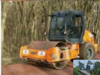
Verdichten der Tragschicht
