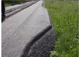
Spuraufweitung um 20 cm für Einfahrten und Einmündungen
