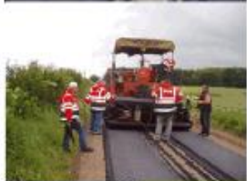
Asphaltspurbahnfertiger im Einsatz
