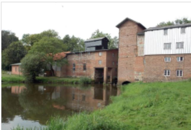
*Wassermühle an der Wümme in Scheeßel (Landkreis Rotenburg/Wümme). Blick auf das denkmalgeschützte Mühlenensemble vom Unterwasser. Der Auslass der zuletzt aktiven Francis-Turbine befindet sich in dem, im Bild links erscheinenden Gebäudeteil, unter der aufgeständerten Gebäudeecke, der Auslass der zweiten Turbine unter der bogenartigen Öffnung des rechten, turmartig erhöhten Gebäudeteils. Foto: NHB.*
