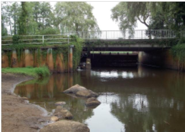
*Wassermühle an der Wümme in Scheeßel (Landkreis Rotenburg/Wümme). Brücke und Klappenwehr am Wehrarm der Wümme. Unterhalb der Brücke, im Bild links, an der Spundwand, ist die Fischtreppe zu erkennen, die nach Planungen des NLWKN durch eine funktionsfähige Fischaufstiegsanlage ersetzt werden soll. Foto: NHB.*
