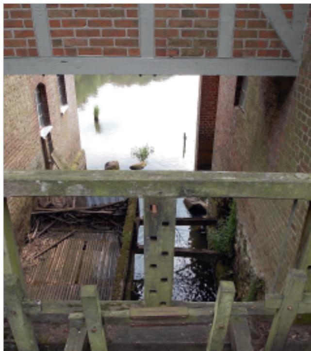
*Wassermühle an der Wümme in Scheeßel. Wehr zwischen den Gebäudeteilen am Mühlarm mit Blick ins Unterwasser; im Bild links der Aalfang, im Vordergrund die Schütztafel. Nach Ansicht des Mühlenbesitzers sollte eine neue Fischaufstiegsanlage hier hinein gebaut werden. Foto: NHB.*
