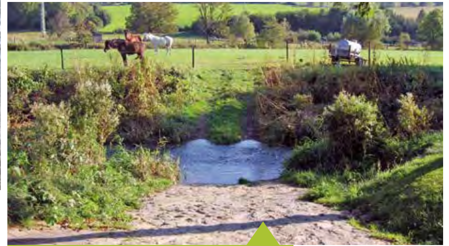
Furten sind zunächst von selbst entstanden durch ständiges Befahren. Später befestigte man sie oder verringerte die Wassertiefe, indem man den Bachlauf verbreiterte (Amelgatzen, LK Hameln-Pyrmont, Foto: CW).
