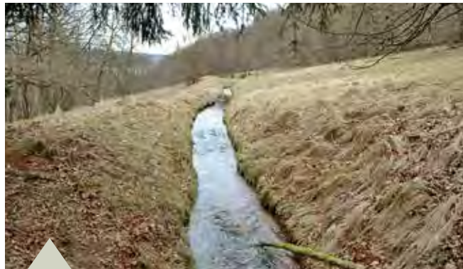
Mit Hilfe von Mühlgräben (oben: bei Hemeln, LK Göttingen, Foto: CW) wurde Bachwasser über weite Strecken zu Wassermühlen geleitet, damit es dort aus großer Höhe über das Mühlrad fließen konnte (links: bei Bad Essen, LK Osnabrück, Foto: NHB).
