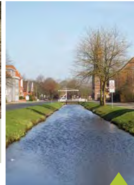
In Ostfriesland wurden Fehnkanäle angelegt, um Moore zu entwässern. Manche waren zugleich Leitlinien der Besiedlung (Rhauderfehn, LK Leer, Foto: KK).
