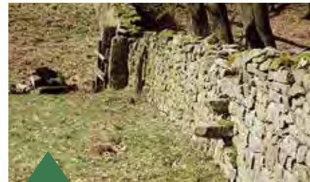
Trockenmauern erlangen ihre Statik nicht durch Mörtel sondern nur aus dem kunstvollen Zusammenfügen passender Steine. In steinreichen Gebieten sind sie besonders verbreitet (bei Neuhaus im Solling, LK Holzminden, Foto: CW).
