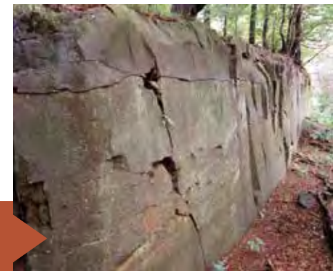
Steinbrüche (hier im Deister, Foto: CW) dienen zur Baustoffgewinnung. Größere Vorkommen prägten die Bauweise ganzer Landstriche.
