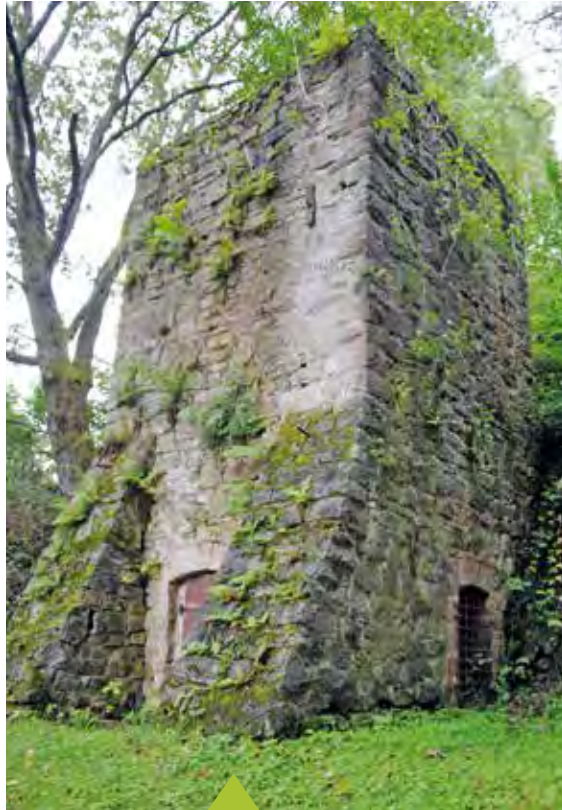
In Kalköfen wurde Kalkgestein bei über 1.000° C in Brandkalk umgewandelt. Kalk diente z.B. als Baustoff, zur Desinfektion oder zur Düngung (bei Heinsen, LK Holzminden, Foto: HL).
