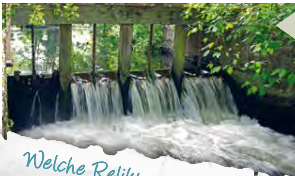
Dieses Wehr in Lüllau (LK Harburg, Foto: AHO) diente zur Wiesenbewässerung (s. S. 13).
